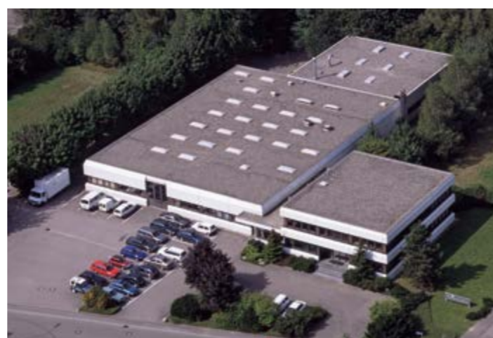
Das neue 2000 qm große Betriebsgebäude für Produktion, Administration und Präsentation kann bezogen werden
